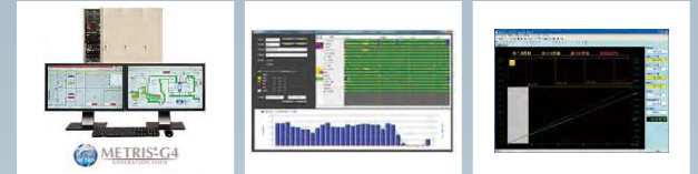
集中監視・制御システム 稼働監視システム 電力監視システム
